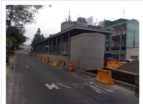
Avance de obra de la estación Parque Lira de la Ruta B (Septiembre de 2008)|250px
