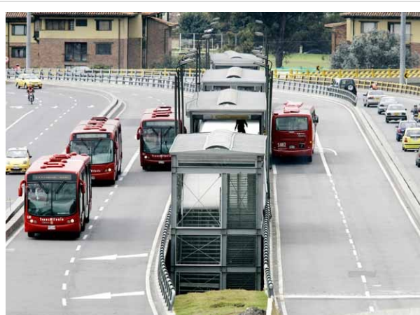
Estación elevada del sistema TransMilenio en las Avenidas Suba y Boyacá, Bogotá.
